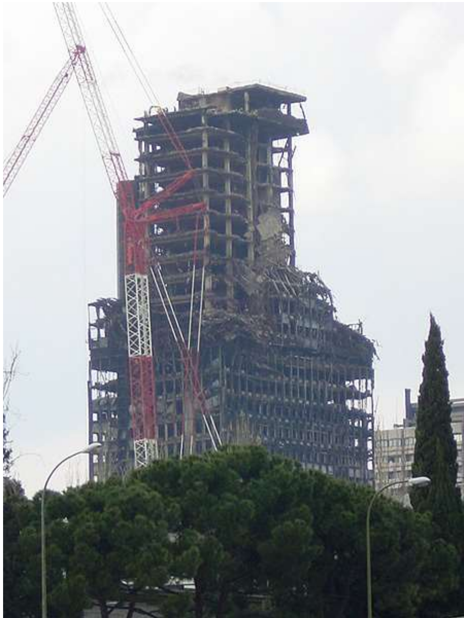
a_marga -Flickr . Edificio Windsor después del incendio (CC BY-SA)
