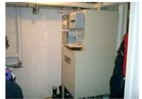
Los recuperadores son equipos que permiten aprovechar el calor del aire de extracción y cederlo al aire de ventilación. Es muy importante que los caudales de aire no se mezclen entre ellos ya que estaríamos reintroduciendo los contaminantes al interior de las estancias. Pueden recuperar calor sensible, calor latente o ambos.
