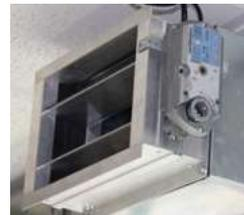
Los **actuadores** son elementos que utilizan energía para introducir variaciones en un proceso automatizado y según la energía que utilizan se clasifican en:
