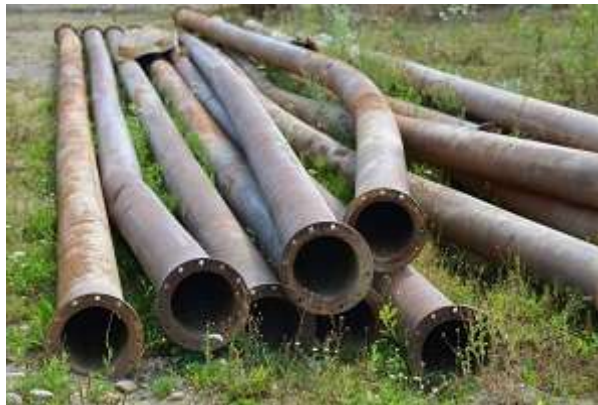
Tuberías de acero deteriorados. (CC0)
